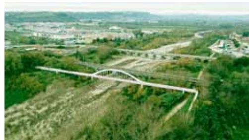
Chienti verrà realizzato in carpenteria metallica e si presenta con un impalcato unico ad andamento lineare, costituito da 3 campate, un arco centrale a sezione variabile e dei piloni di appoggio degli elementi strutturali portanti in conglomerato cementizio armato. La pendenza massima lungo le rampe di accesso al ponte è del 5%.
